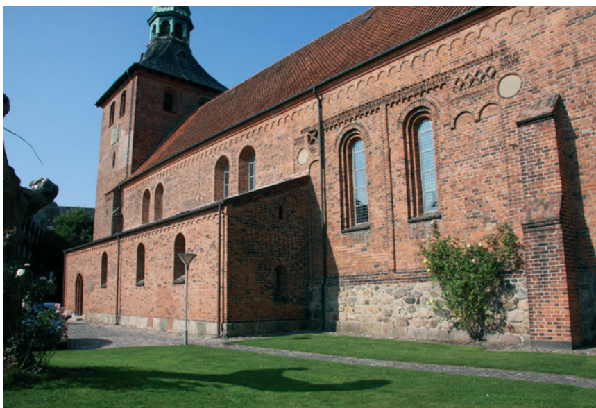
Fig. 3.4. Sankt Nicolai Kirke set fra sydøst. Kirken består af en række bygningsdele fra lidt forskellig tid. Under den ældste del af koret findes der en høj naturstenssokkel, der er en rest af en ældre kampestenskirke. O. år 1200 blev koret erstattet af en teglstensbygning i en meget pyntelig stil. Kort tid efter blev skibet erstattet af en basilika i en temmelig nøgtern stil importeret fra Lübeck. Tårnet i vest er en tilføjelse fra tiden op mod 1500. Det fik et barokspir i 1700-tallet. Foto: HKK 2016.
